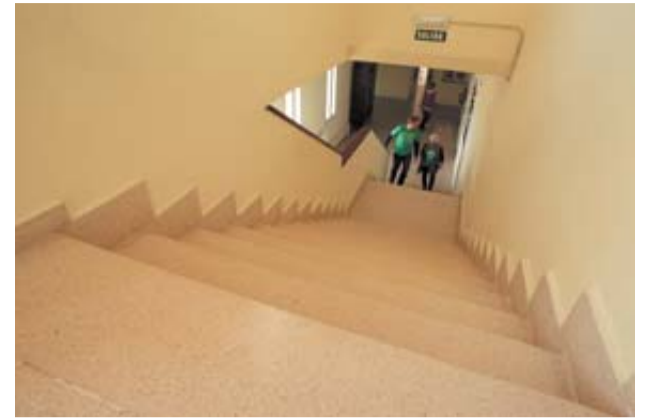
ESCALERAS SIN PASAMANOS Algunas escaleras no disponen de pasamanos, lo que aumenta el riesgo de caídas. N.G.L.
