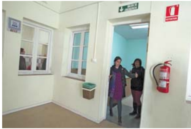
SALIDAS DE EMERGENCIA ESTRECHAS Varias de las salidas de emergencia del centro no tienen la anchura necesaria. N.G.L.
