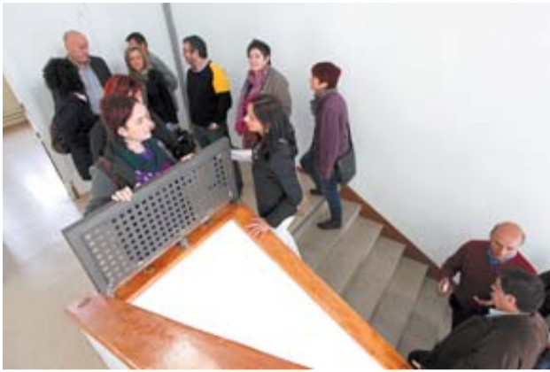
ESCALERA INSEGURA El pasamanos de esta escalera es tan bajo que se tuvo que colocar una plancha para evitar caídas. N.G.L.
