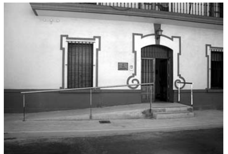
CASTEJÓN Imagen de la rampa que se ha construido para acceder al ayuntamiento de la villa ferroviaria. CEDIDA
