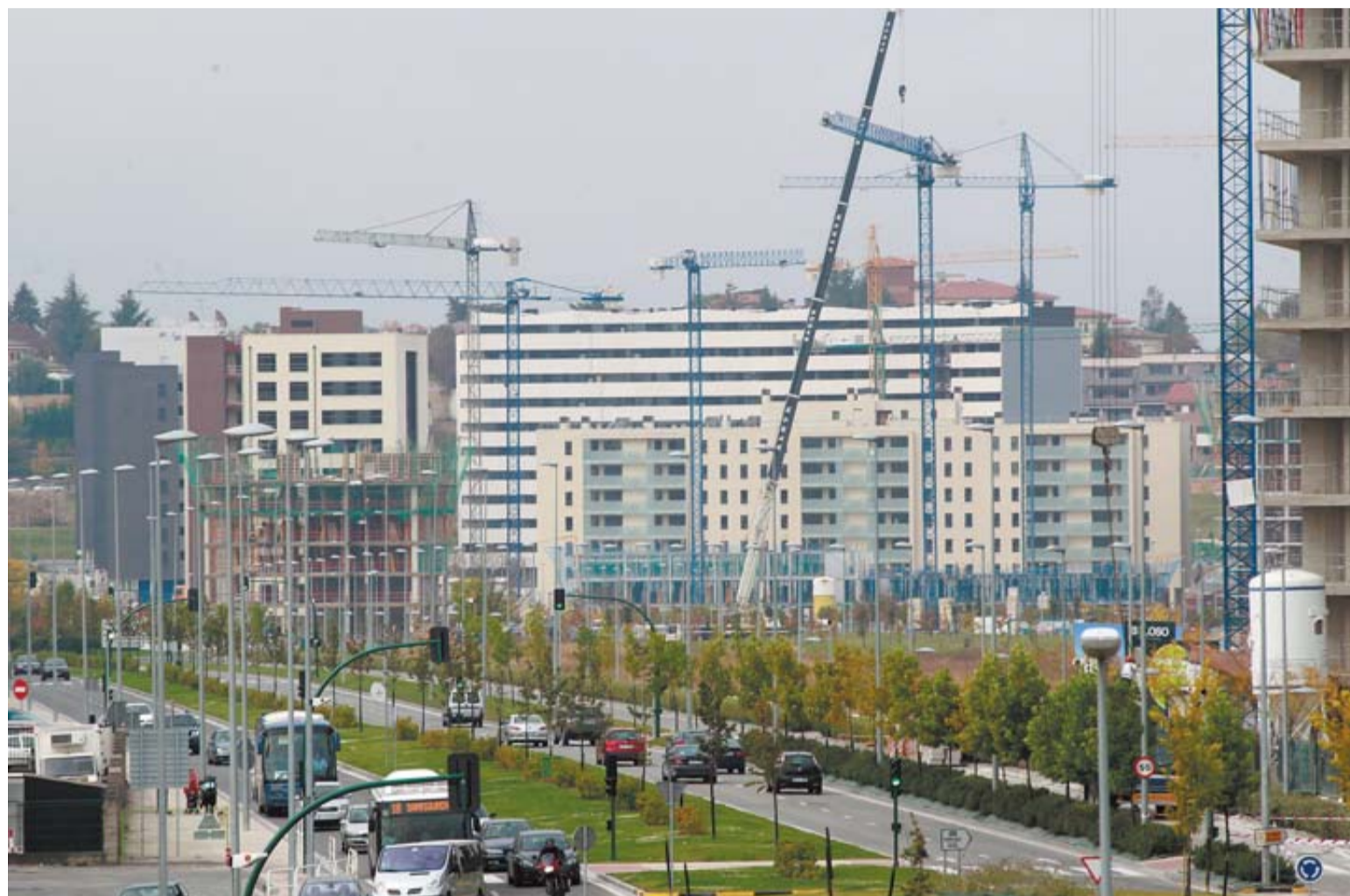
Viviendas en construcción en Ripagaina.
