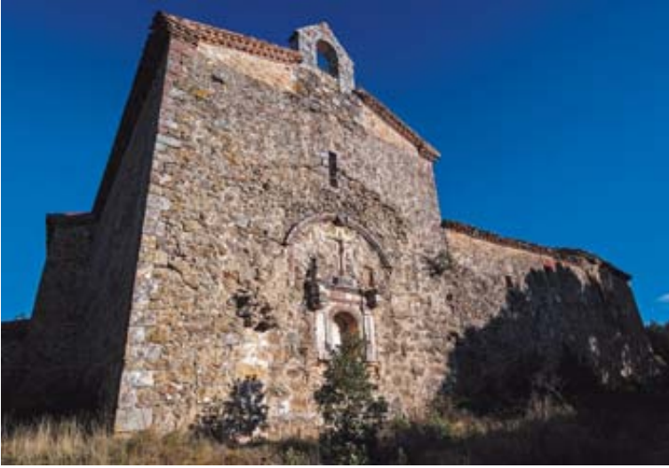
3 Arquijas La ermita, a unos dos kilómetros del pueblo, se restauró hace un par de décadas pero no se tocó entonces la hospedería anexa. MONTXO A.G.
