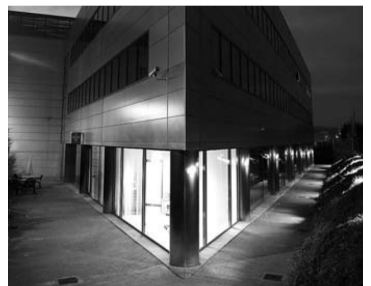
Edificio de Asepeyo en la capital navarra.
