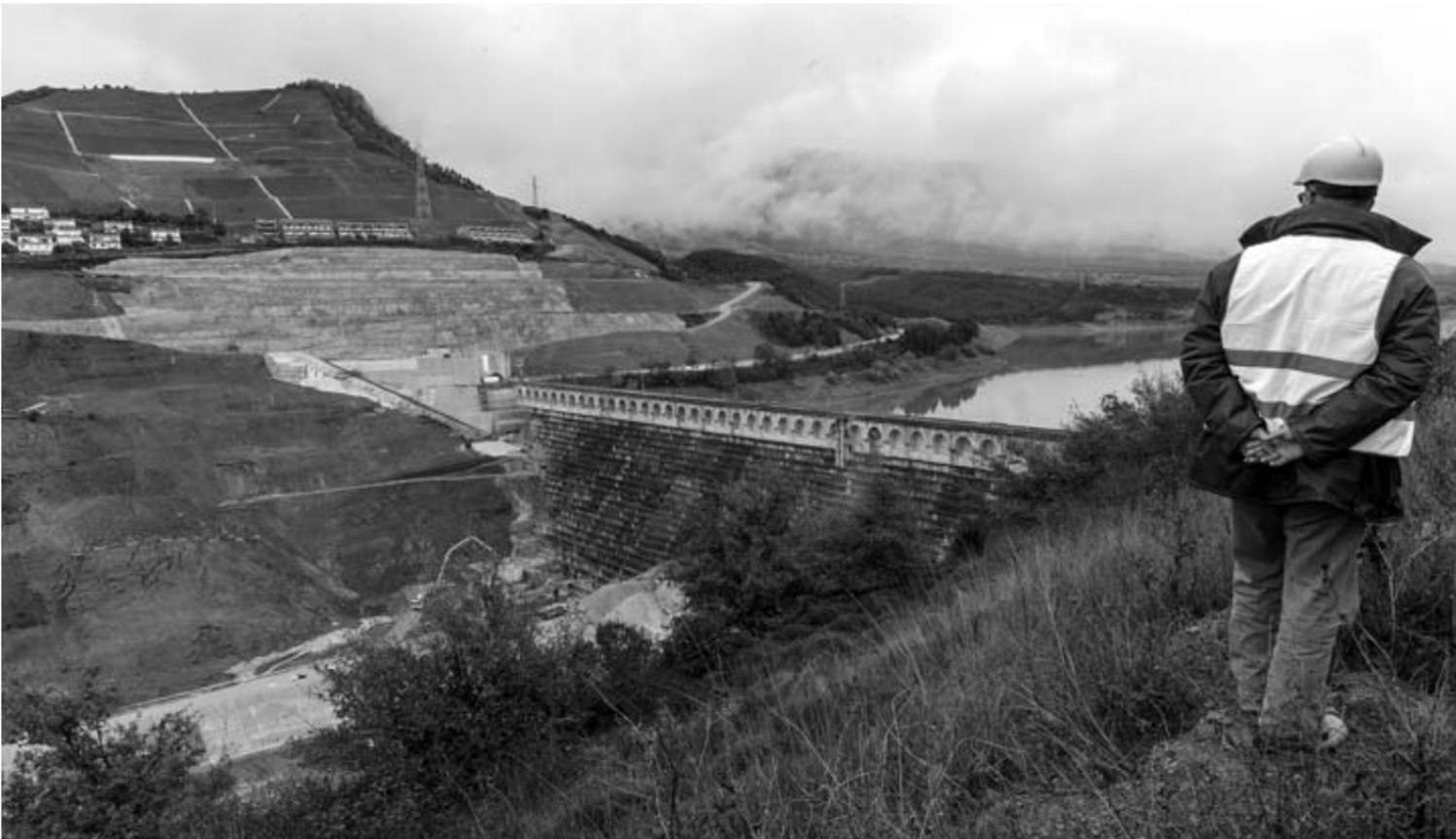
Imagen que muestra la ladera derecha de la presa, en la que en octubre se produjo el derrumbe de un talud. Arriba, las urbanizaciones. JESÚS CASO
