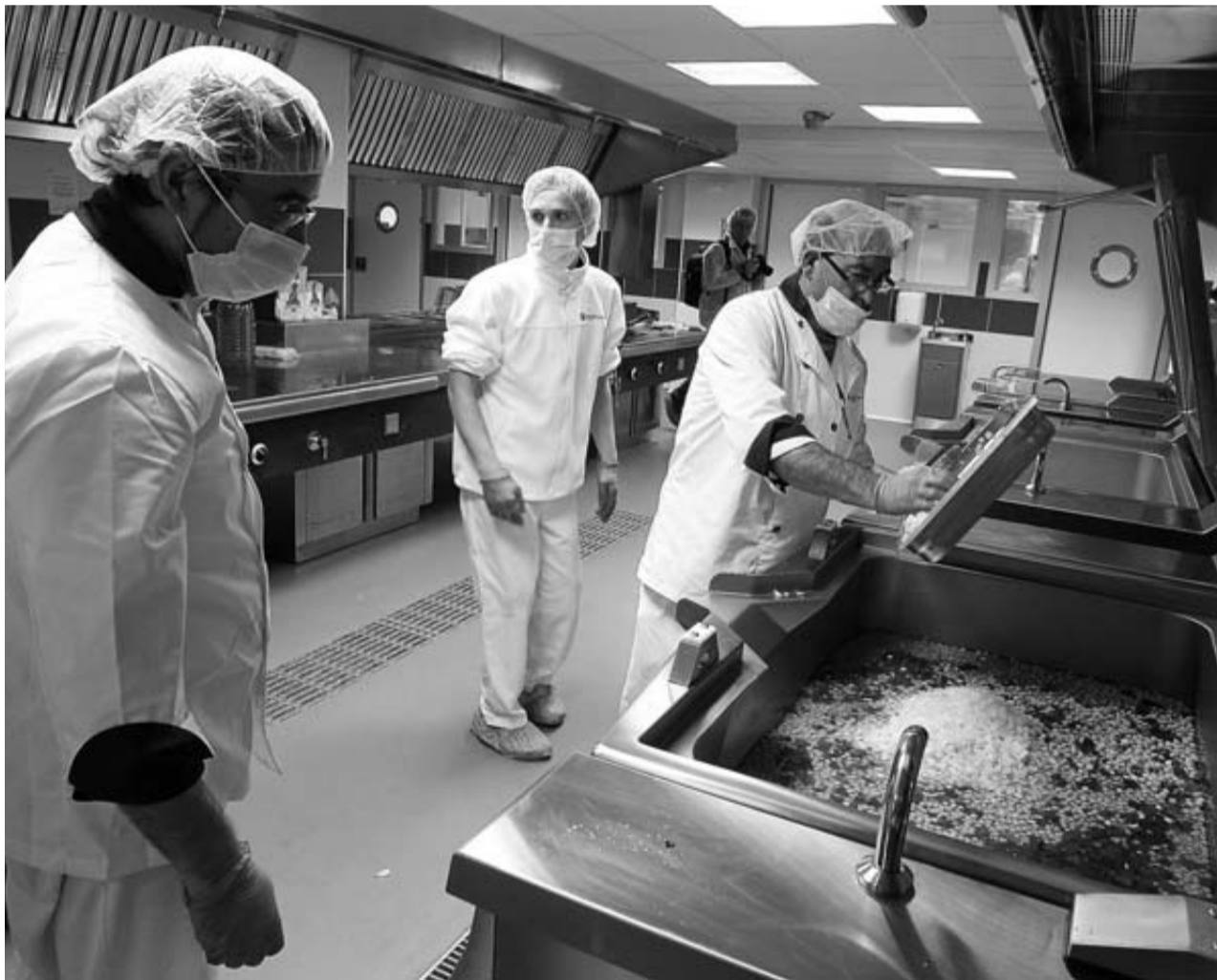
Imagen de las nuevas cocinas del Complejo Hospitalario de Navarra.
