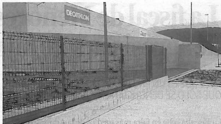
A la izquierda, la puerta desmontada en el suelo. FOTO: D.N.
