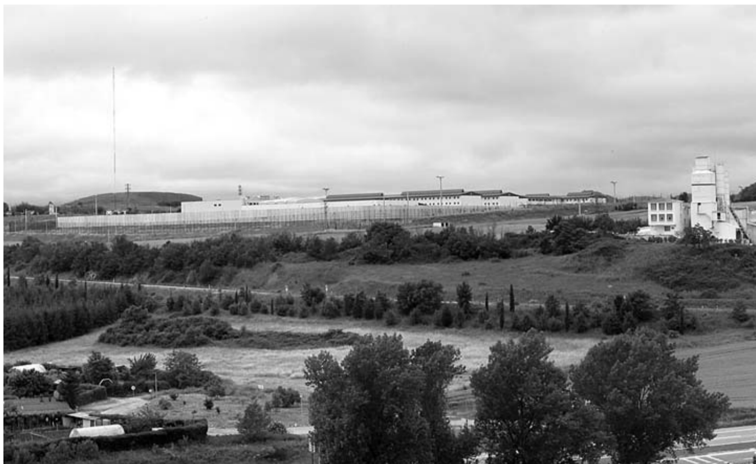
Para construir la nueva cárcel hubo que desmochar la colina de Santa Lucía, entre San Jorge y Berriozar.
