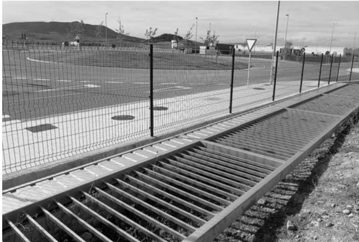
La puerta corredera (tumbada en el suelo) se salió del raíl y cayó encima del vigilante.
