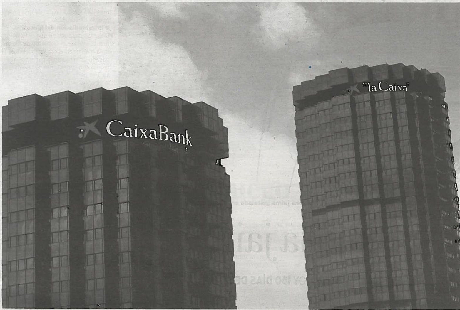
Imagen de las dos torres que componen la sede central de CaixaBank. FOTO: LACAIXA
