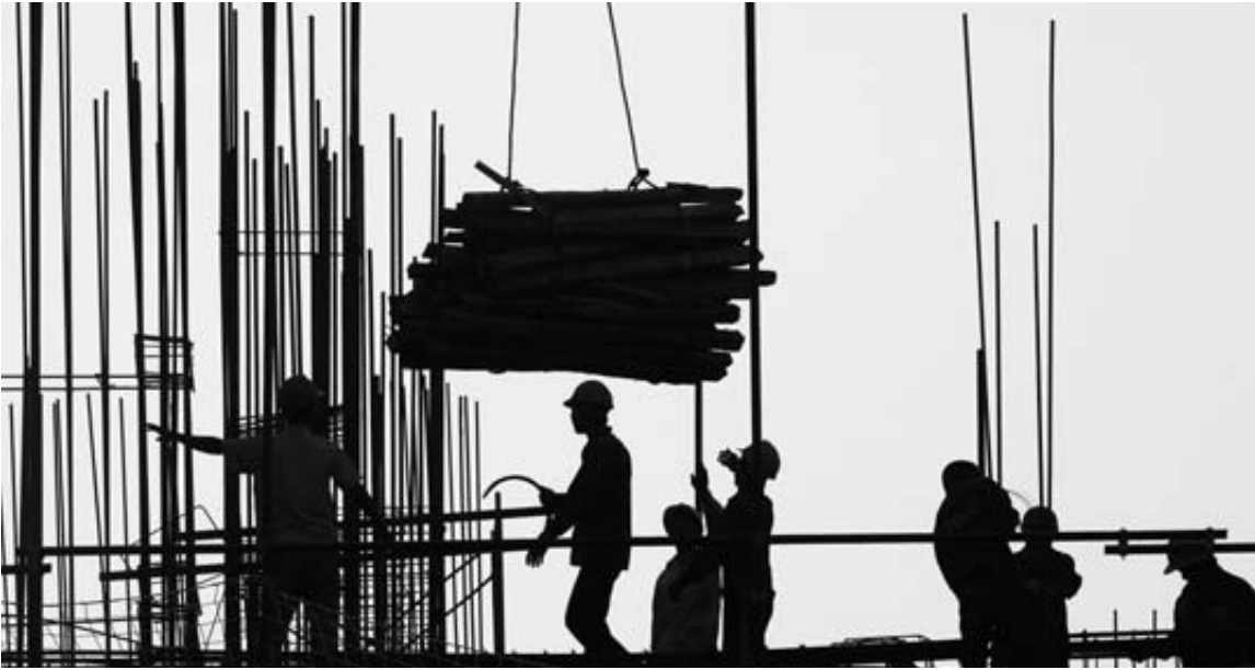
Varios trabajadores de la construcción.
