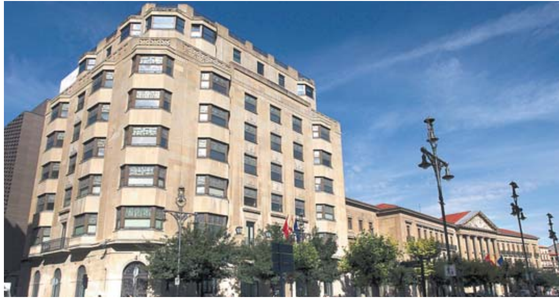
Edificio de Hacienda del Gobierno de Navarra.
