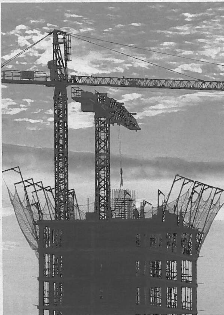
Un edificio de viviendas en construcción en Erripagaña. FOTO: J. BERGASA
