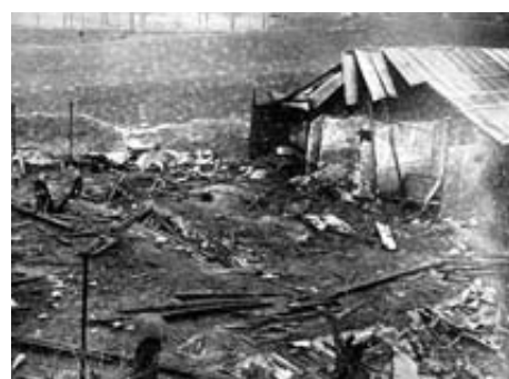
Escombros del cine Belloch. ARCHIVO ARAZURI
