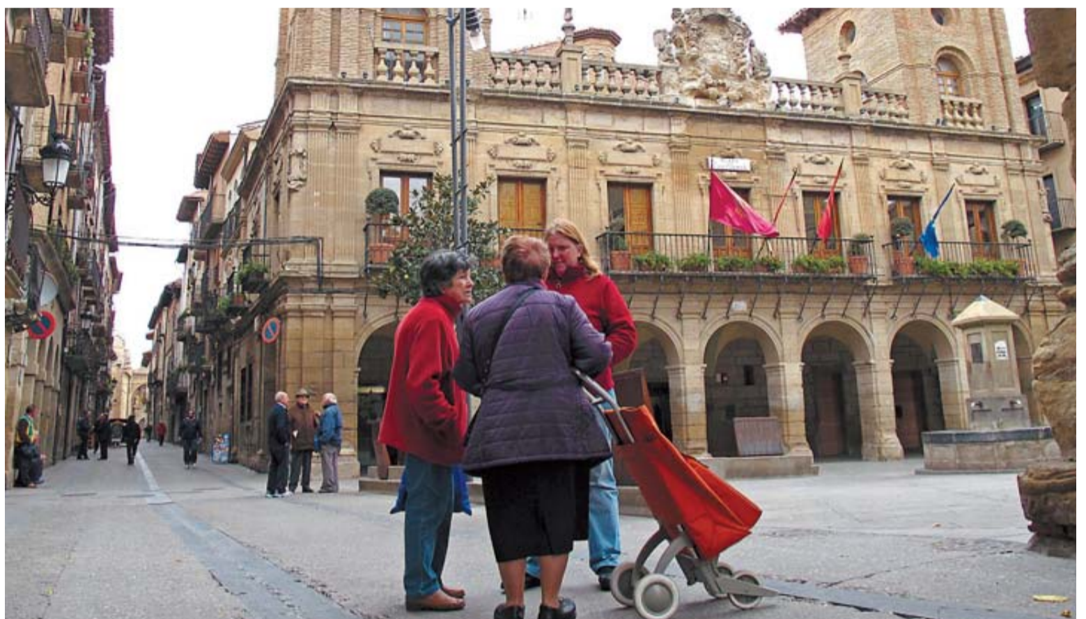
Fachada principal del Ayuntamiento de Viana, cuyo pleno municipal decidió ayer dar el mismo paso que la cabeza de merindad.
