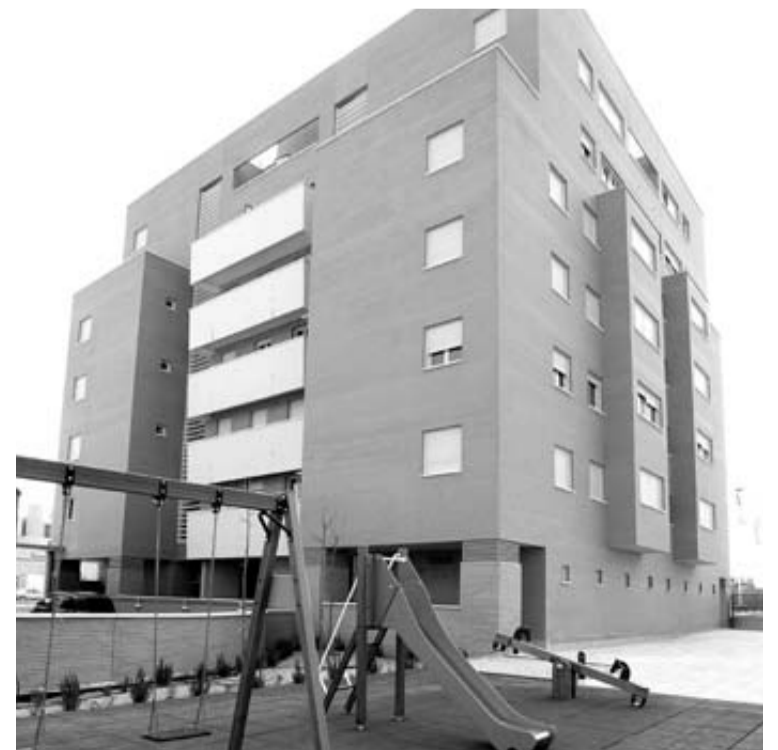
Un edificio de Madrid.
