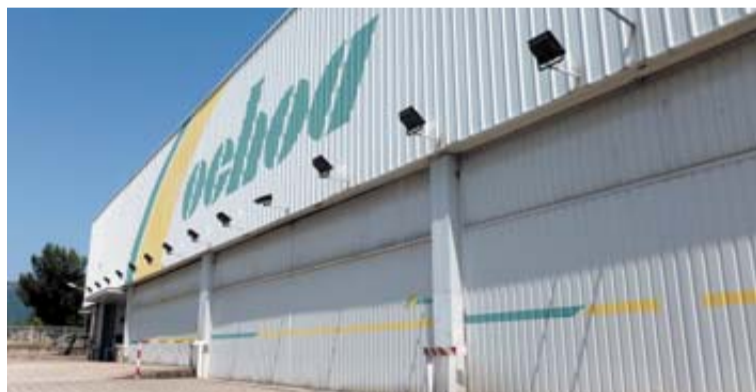
Nave de Transportes Ochoa en el polígono de Landaben.
