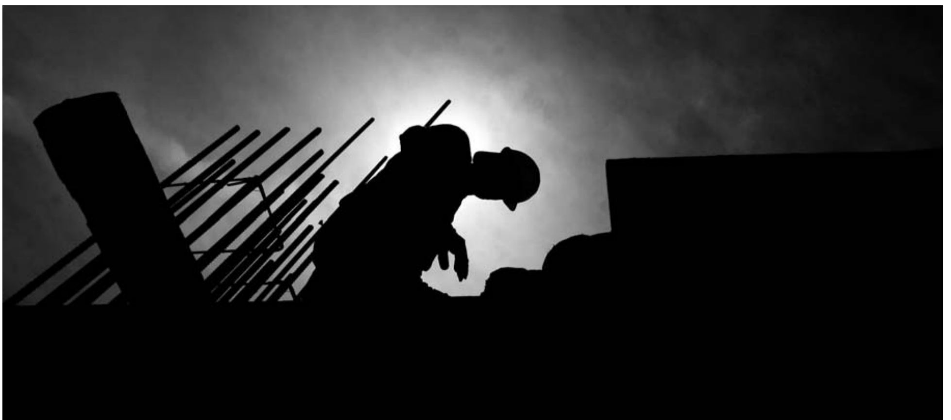
Un albañil autónomo, en pleno trabajo en la construcción.
