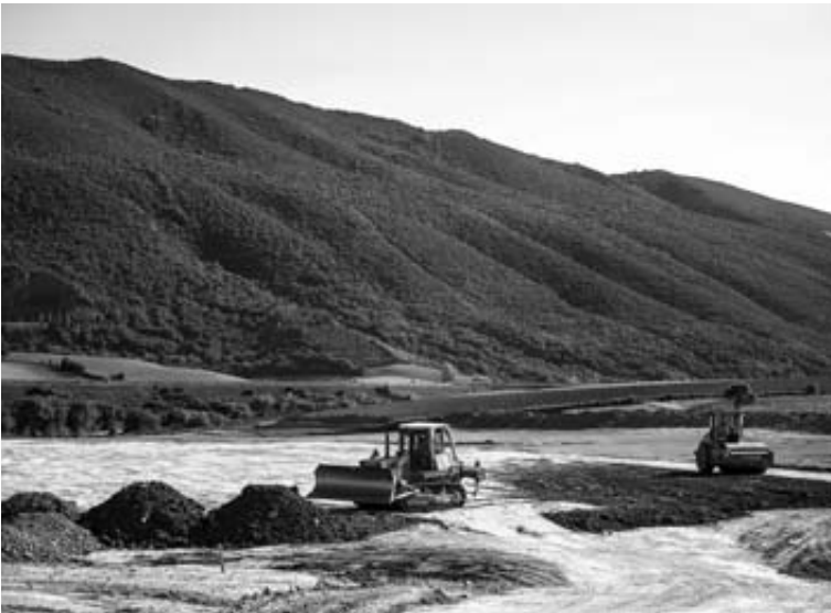
Las primeras obras de la cuarta fase de la CTP.
