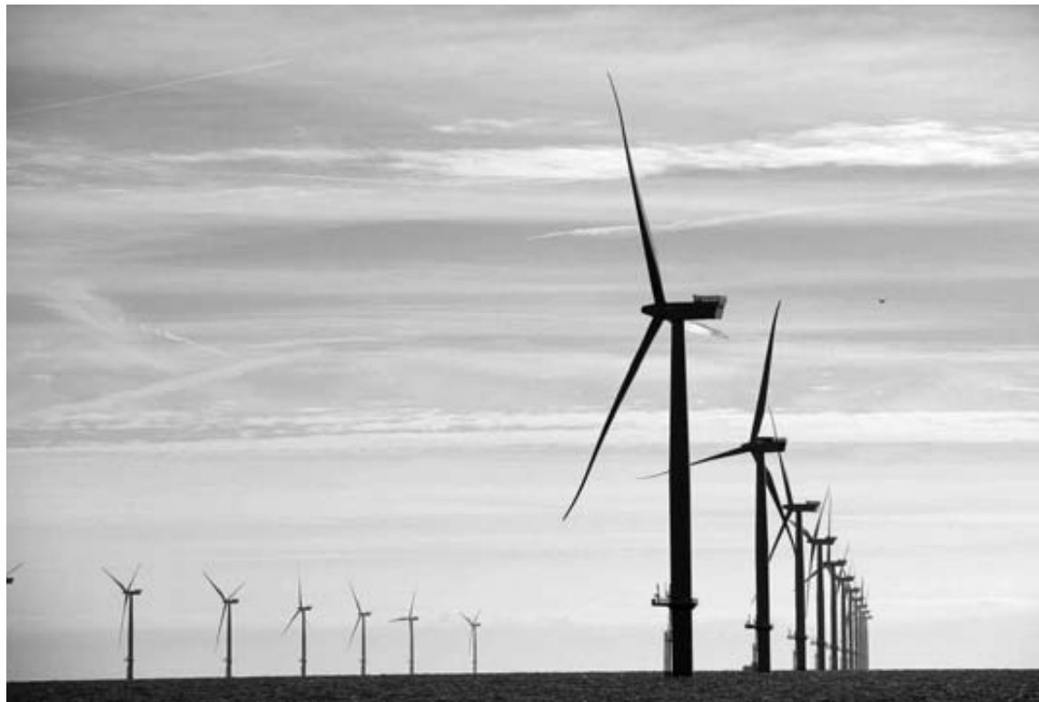
Parque eólico marino de Iberdrola en la costa británica.
