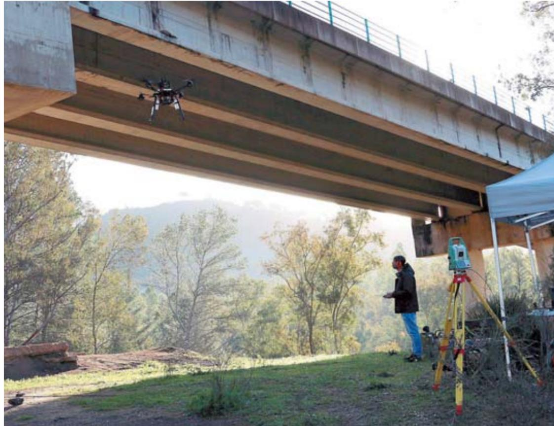
Labores de inspección de un viaducto mediante un dron en Cádiz.
