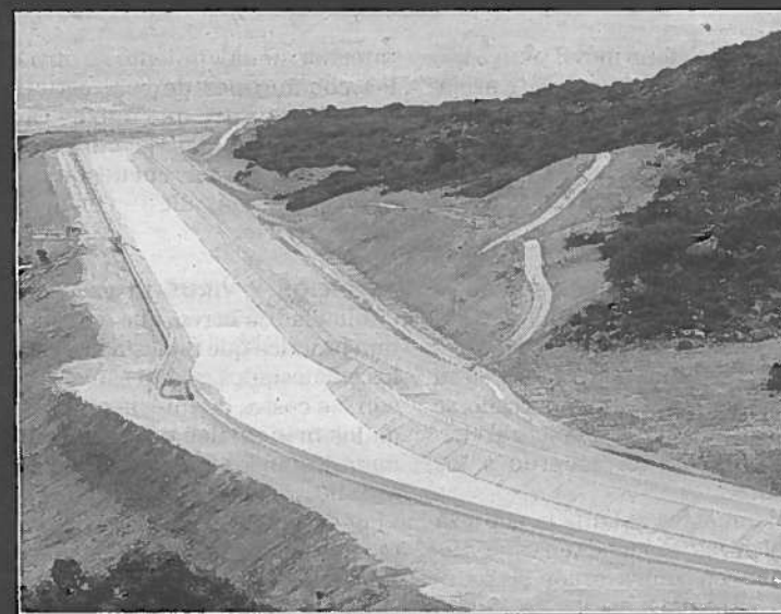
De arriba a abajo, tres de las obras más polémicas del Plan Navarra. Arriba, el Circuito de Los Arcos. En el centro, una recreación del Pabellón Navarra Arena. Abajo, un tramo del Canal de Navarra.
