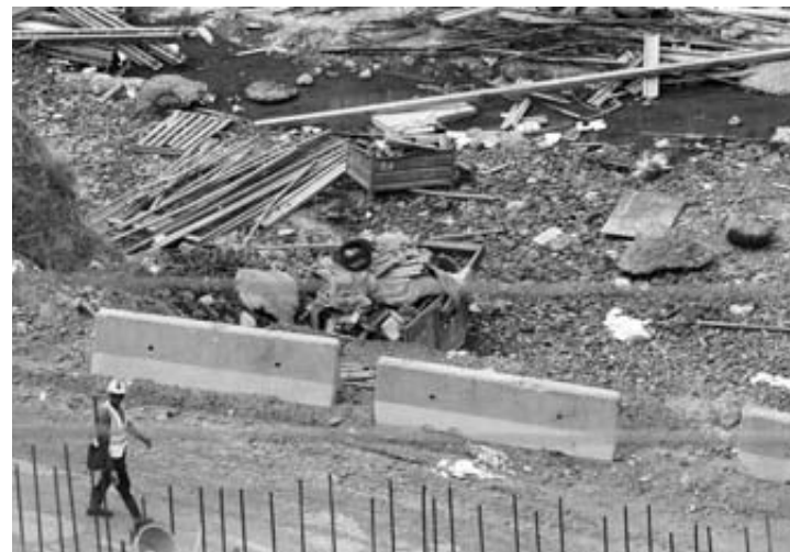
Un obrero camina entre materiales de las obras del canal.
