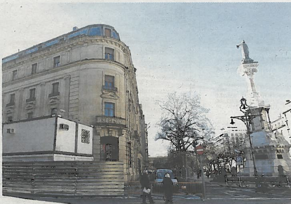
Las vallas ya han sido colocadas en el entorno del Banco de España para las obras.
