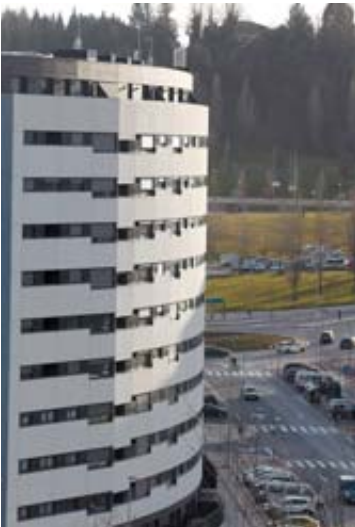
Vivienda protegida en Ripagaina.
