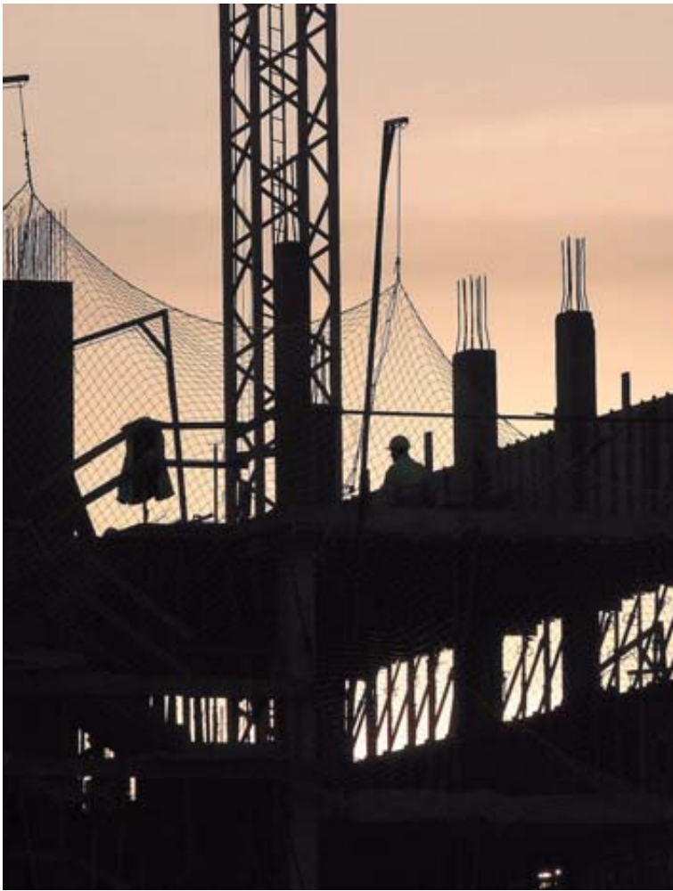
Obreros trabajando en una construcción de Lezkairu.
