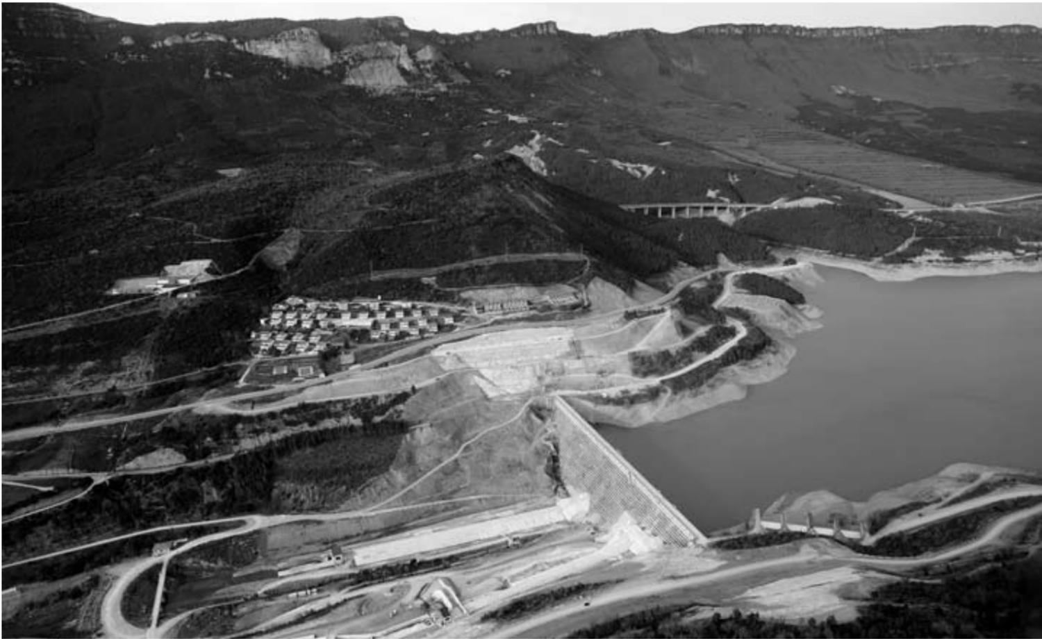
Imagen aérea de las obras en torno a la actual presa de Yesa, sobre la que se apoyará la nueva.
