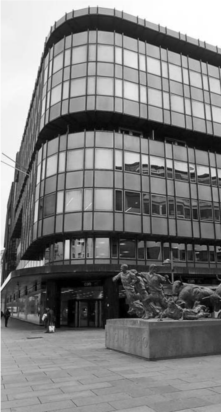
La antigua sede central de CAN, hoy de Caixabank, en la Avda. Carlos III, en Pamplona. JOSÉ ANTONIO GOÑI (ARCHIVO)
