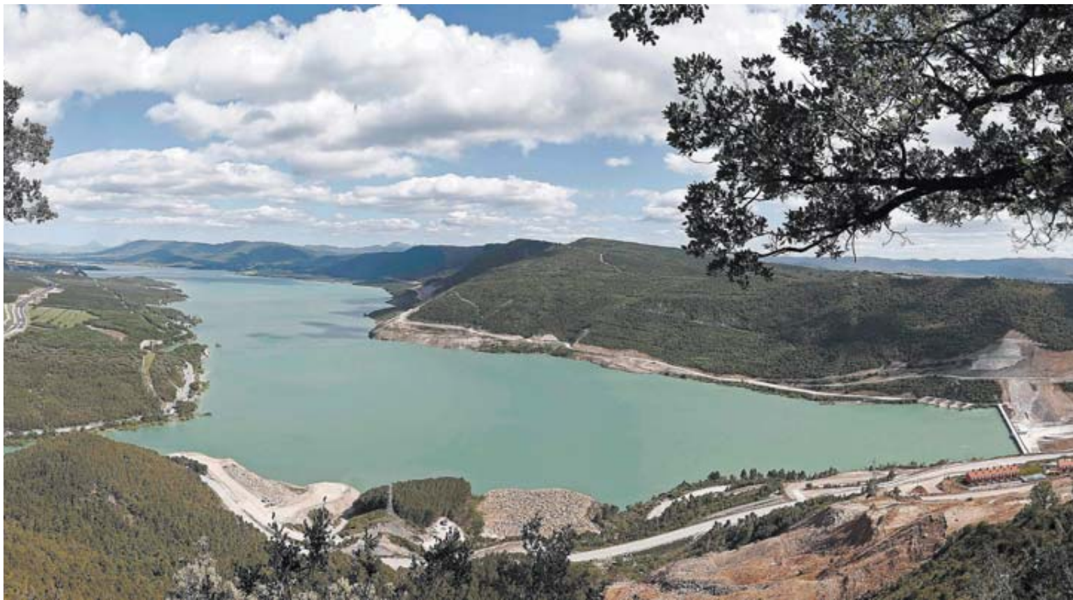
Panorámica del embalse de Yesa, con la presa a la derecha de la imagen.
