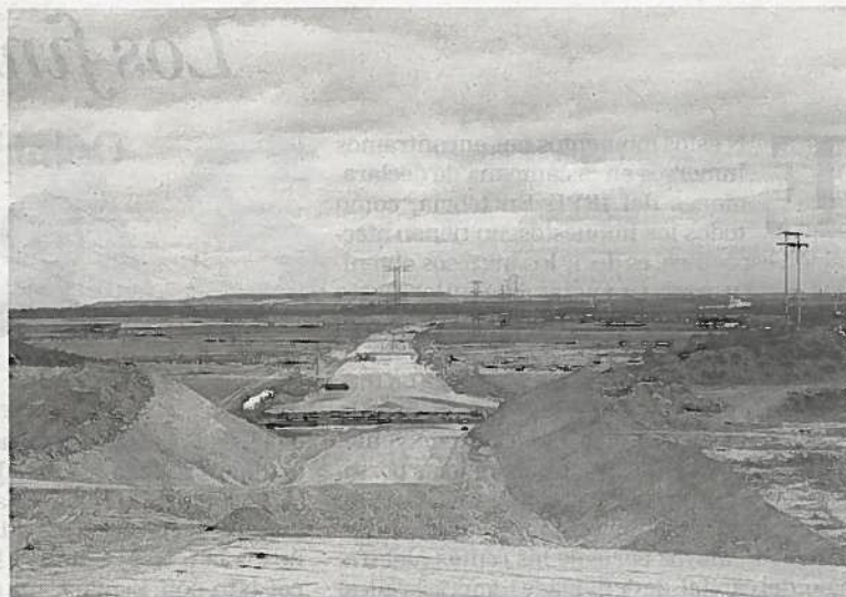
Estado actual de las obras en Cadreita. FOTO: MIGUEL ÁNGEL GALILEA
