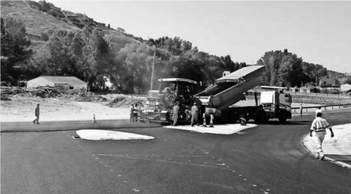
Ayer se ultimaban los trabajos para poder reabrir hoy la carretera.
