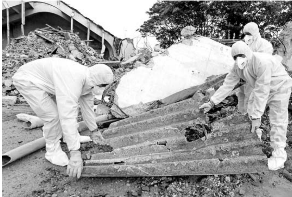
Dos operarios retiran, con trajes especiales, un tejado recubierto de amianto.
