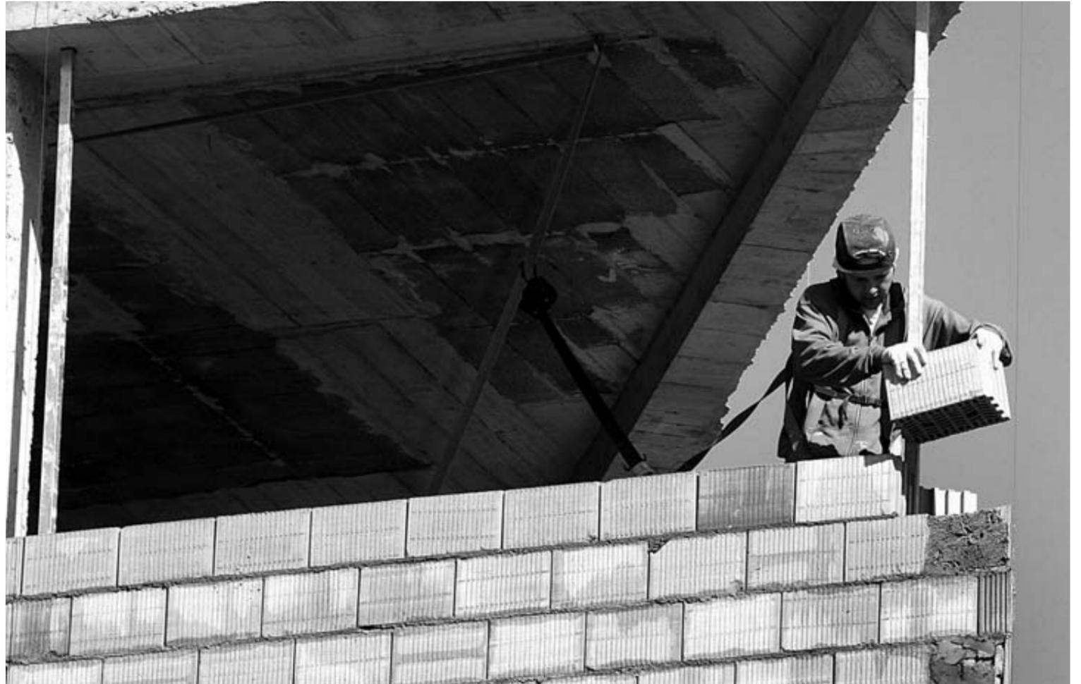
Un albañil levanta un tabique en un edificio en construcción.
