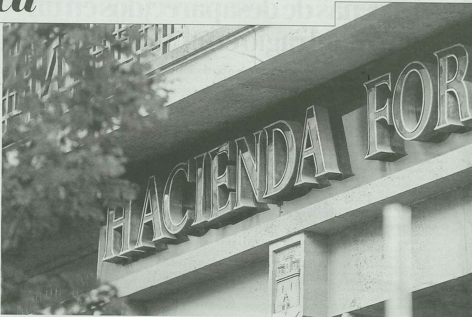
Fachada del edificio de la Hacienda Foral de Navarra, en la Avenida Carlos III de Pamplona. Foto: Iruñapress
