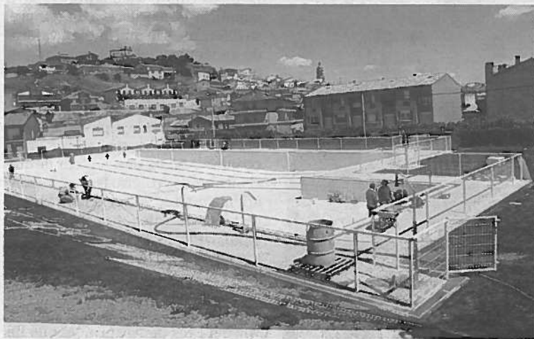
La reforma exterior de las piscinas terminó en 2011. FOTO: ARCHIVO
