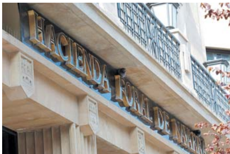
Fachada de la Hacienda foral de Navarra.
