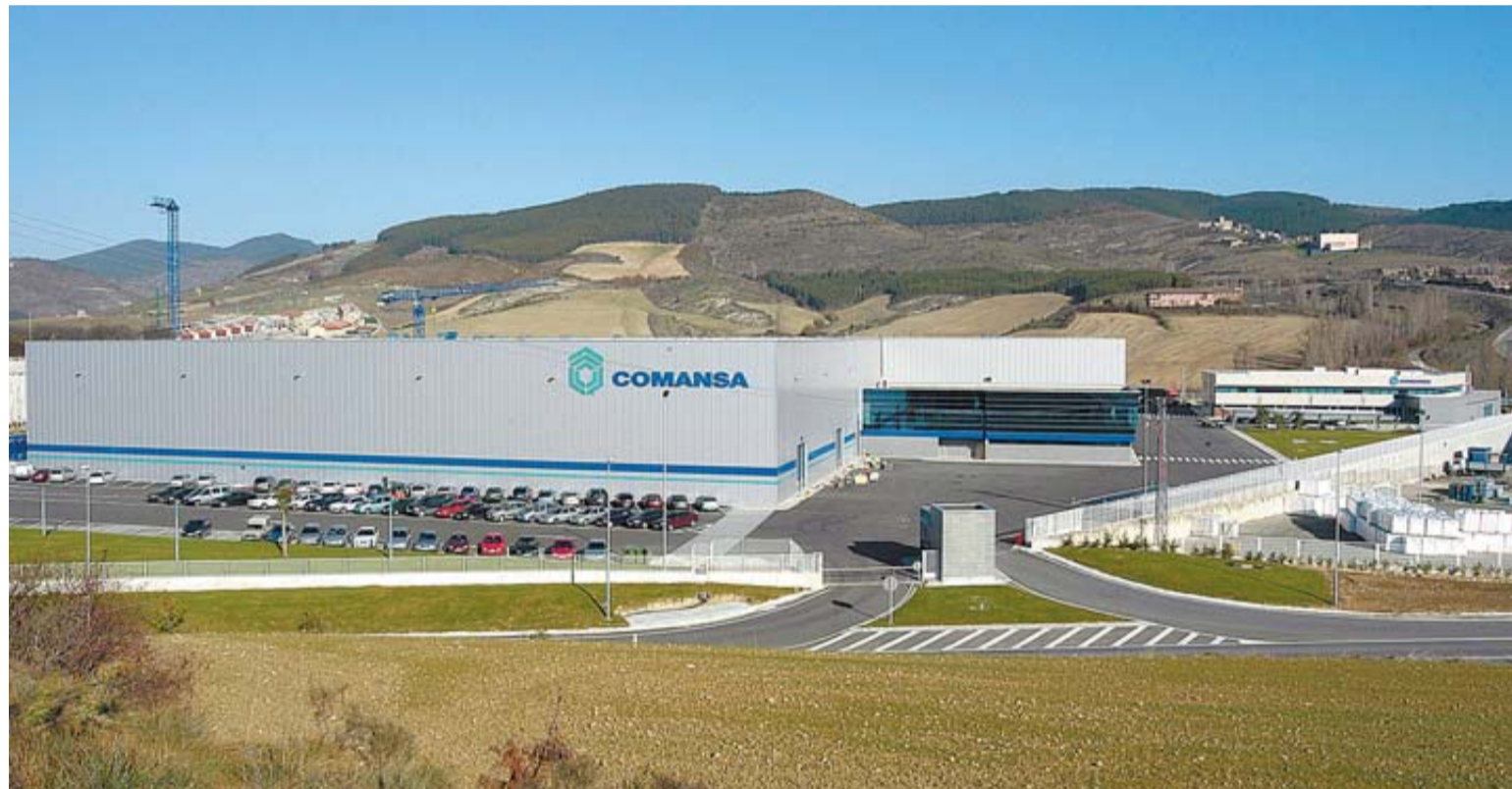
Vista exterior de la fábrica de grúas de Comansa en Huarte.
