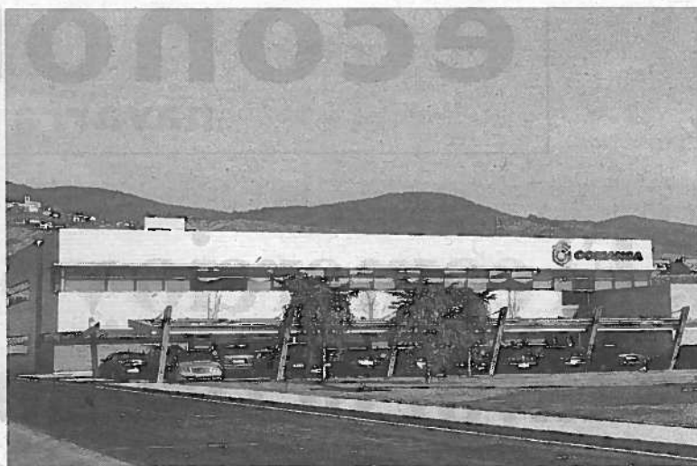
Instalaciones de Comansa. FOTO: PATXI CASCANTE
