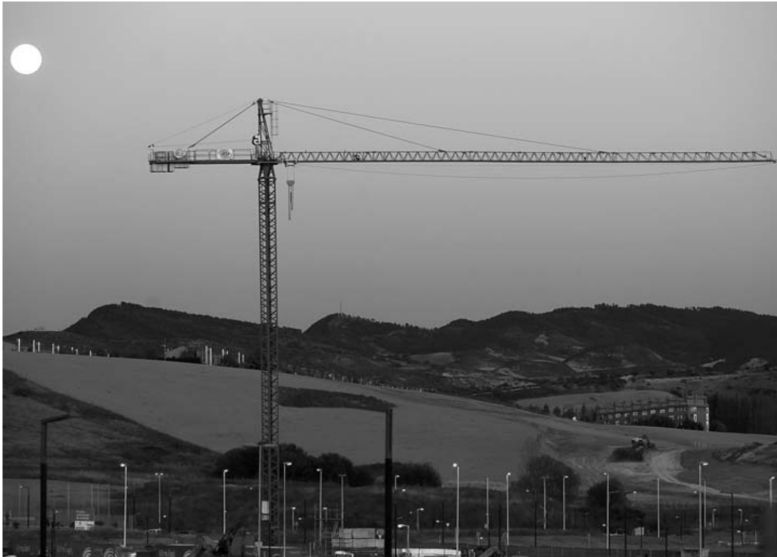
Una grúa en Soto de Lezkairu, uno de los barrios de Pamplona que más ha crecido en los últimos años. Al fondo a la derecha, Mendillorri. EDUARDO BUXENS
