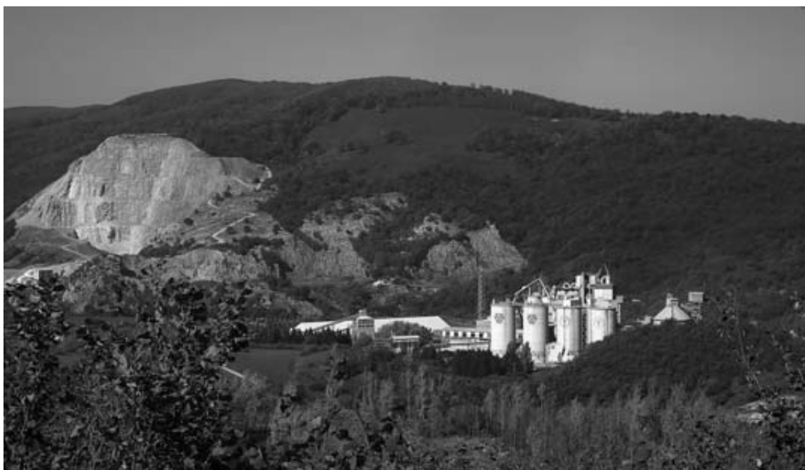
Detalle parcial de Cementos Portland, en Olazagutía.
