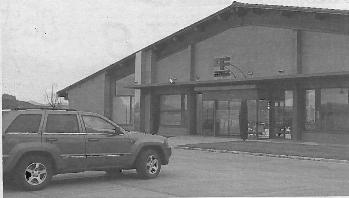
Sede de Construcciones Flores en Gorraiz. FOTO: JAVIER BERGASA
