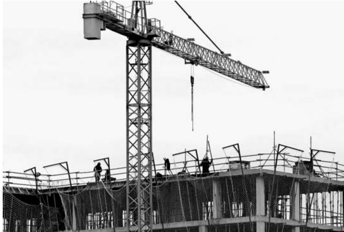
Trabajadores, ayer por la mañana, en las obras de construcción de viviendas en Lezkairu.
