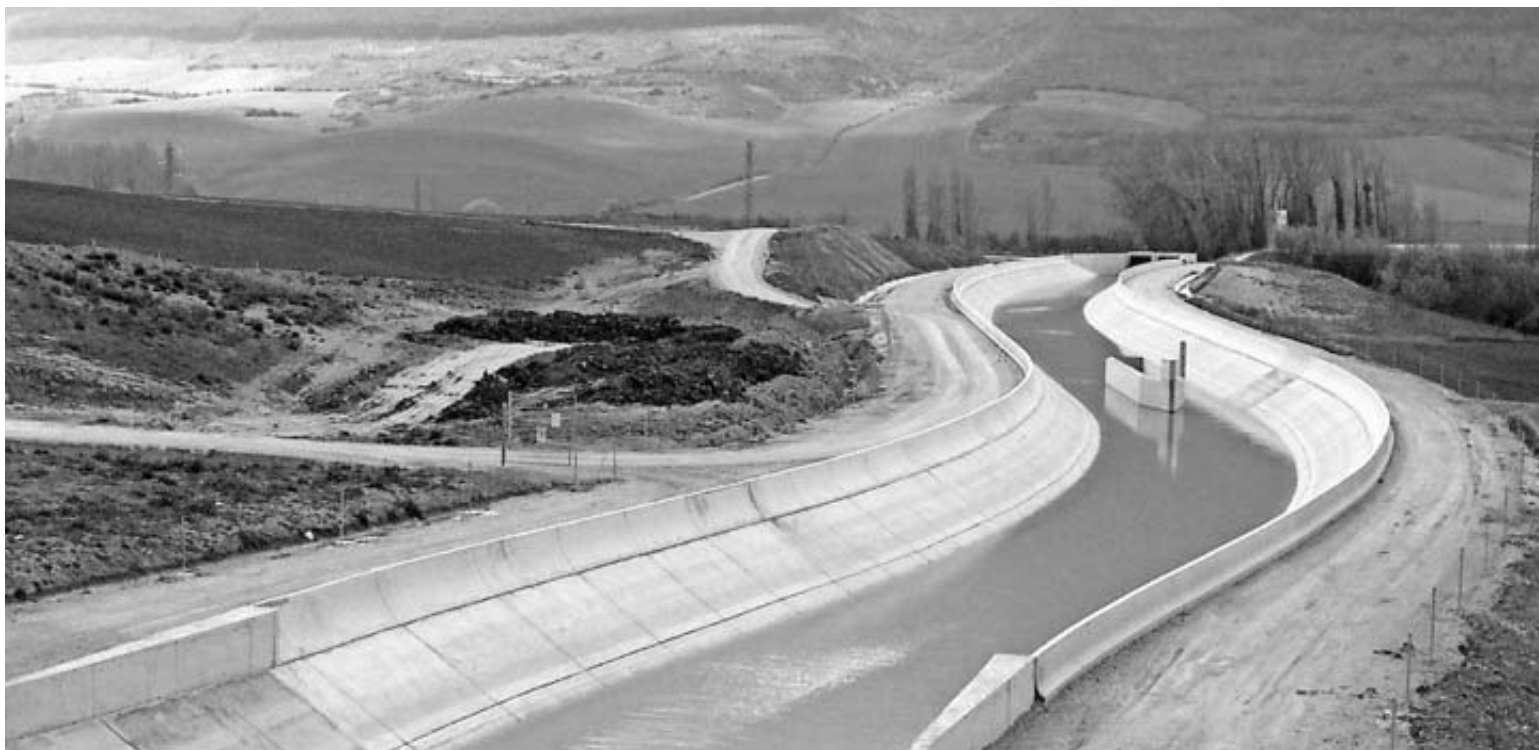
Aguacanal es la sociedad encargada de la explotación de la primera fase de la zona regable del Canal de Navarra.
