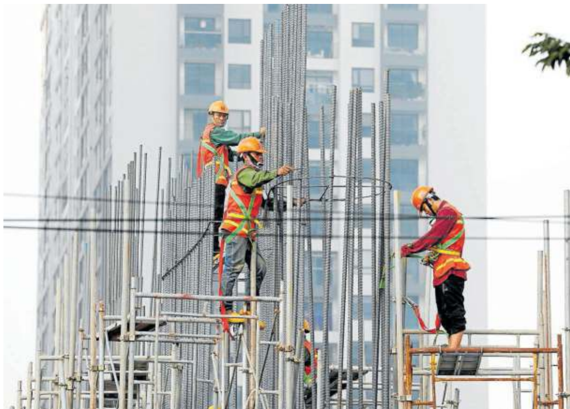
Tres empleados trabajan en un edificio en construcción. Foto: Efe
