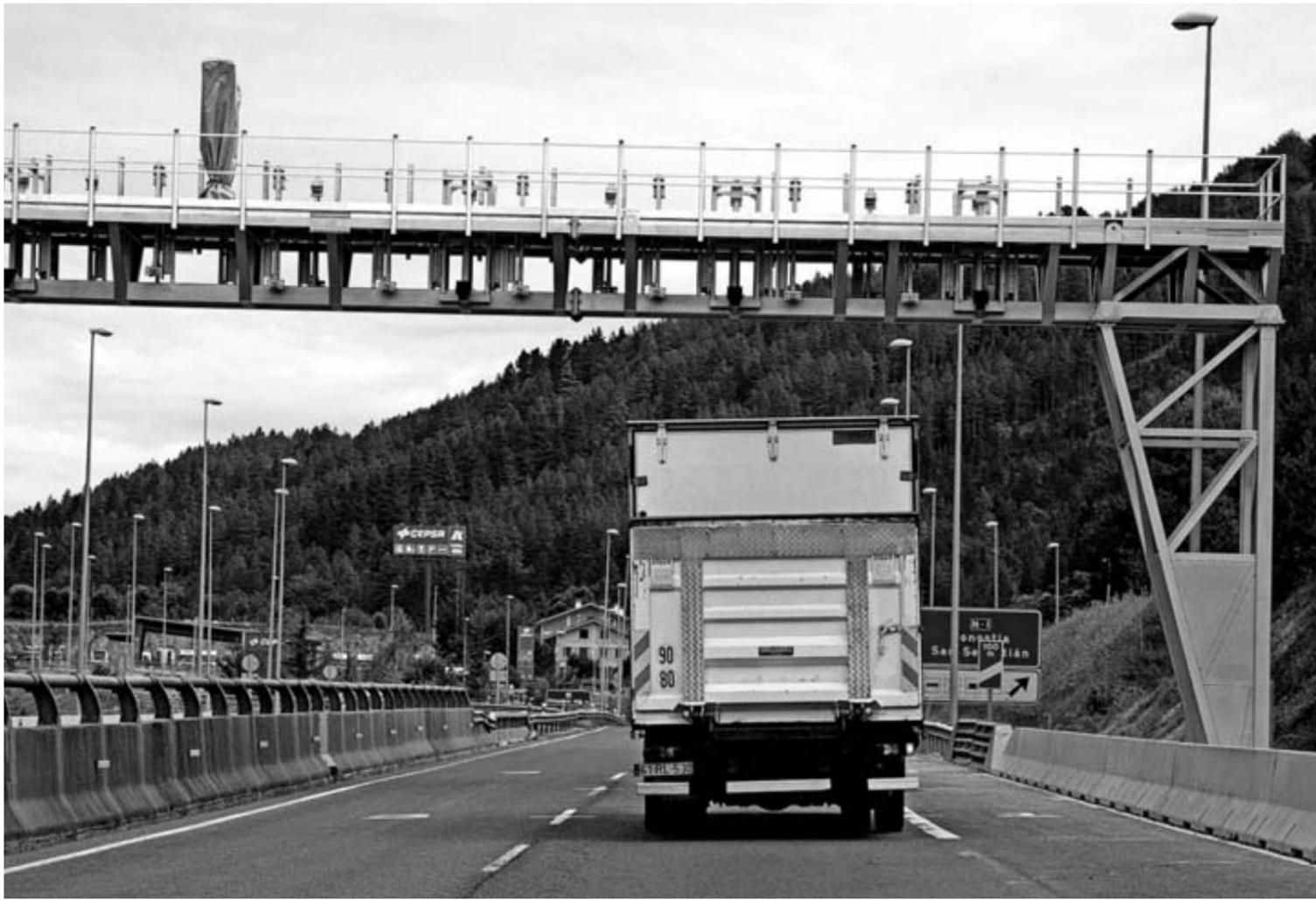
Un camión pasa por debajo del dispositivo de lectura de matrículas para el cobro de peajes en Etxegarate.
