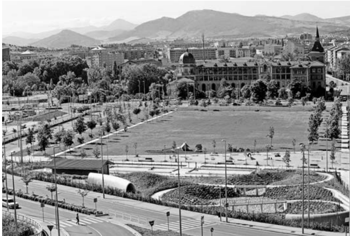
Imagen de 2018 de la explanada donde se levantará el futuro Parque del Tren, en Trinitarios.
