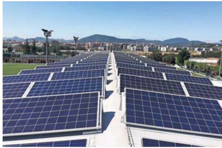
Paneles solares instalados en el colegio Luis Amigó.
